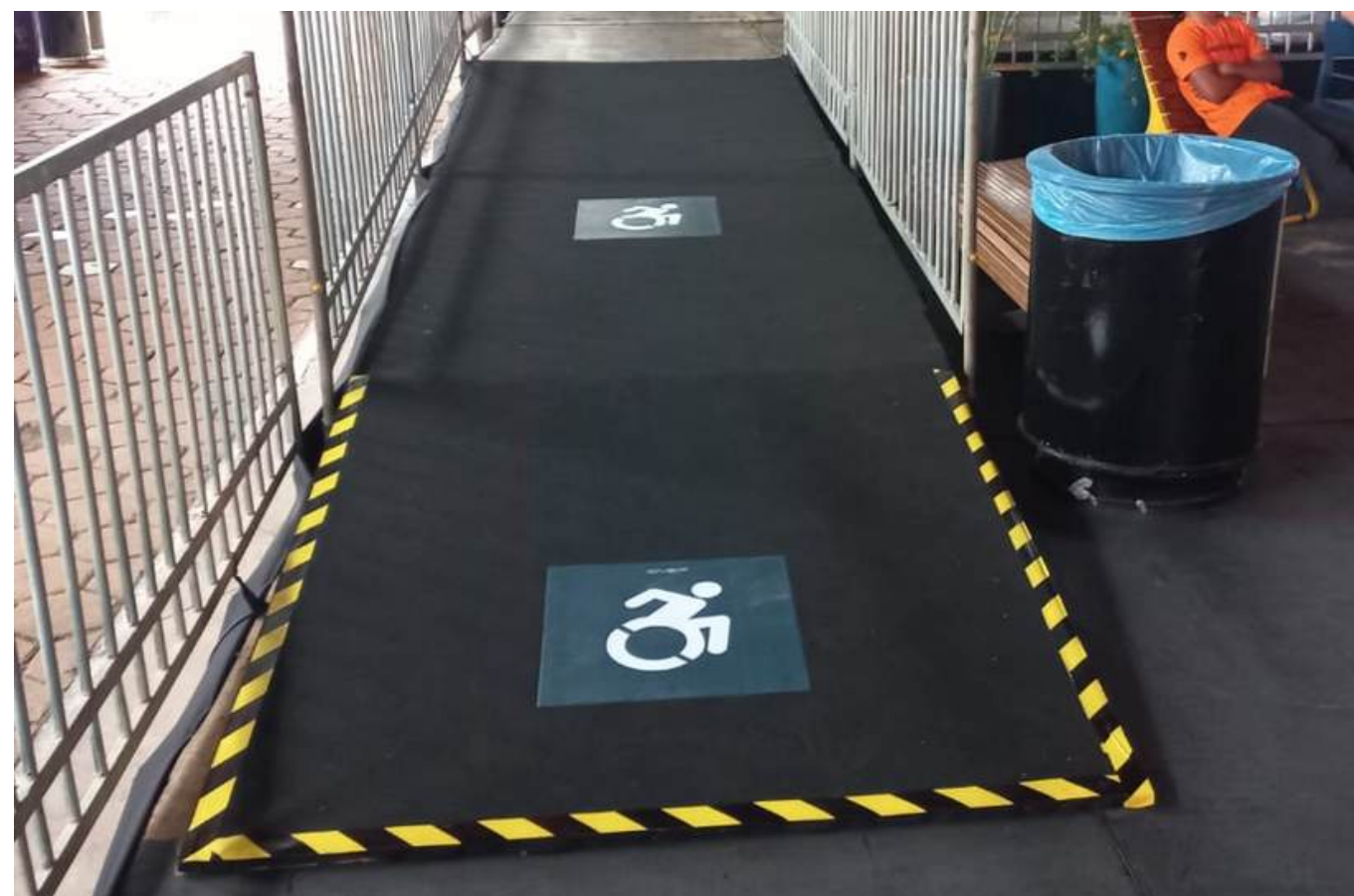
Foto: rampa sinalizada para o elevador PCD.
